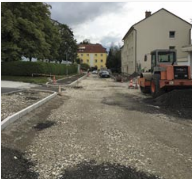
Die Getreidestraße hier noch als Baustelle.
